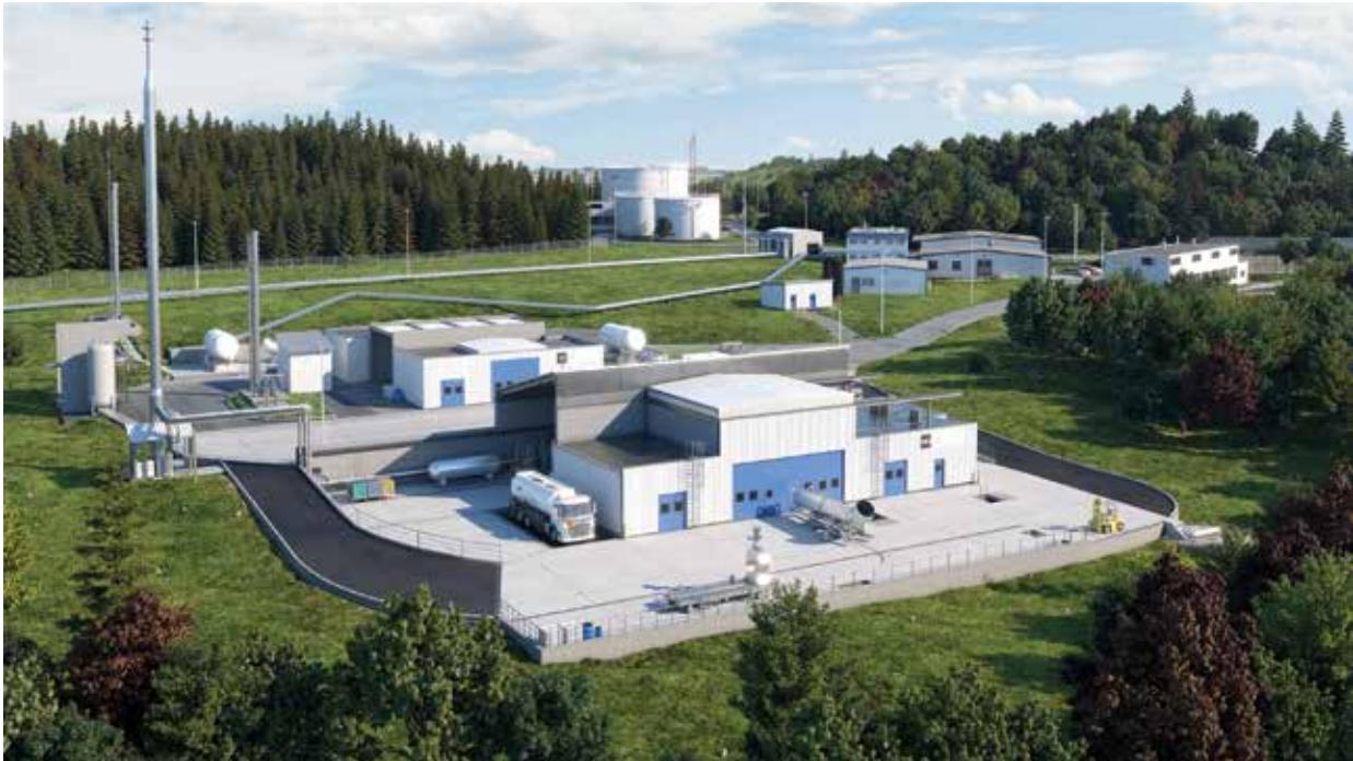
Um zukünftig Turbopumpen sowie gesamte Raketenantriebssysteme im verkleinerten Maßstab testen zu können, verfügt der neue Prüfstand P8.3 über ein Niederdruck-Versorgungssystem. Damit erweitert das DLR Lampoldshausen das umfangreiche Testportfolio um einen wichtigen Aspekt im Bereich Forschung und Entwicklung.
