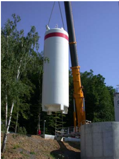
Einbau Tank für flüssigen Wasserstoff
