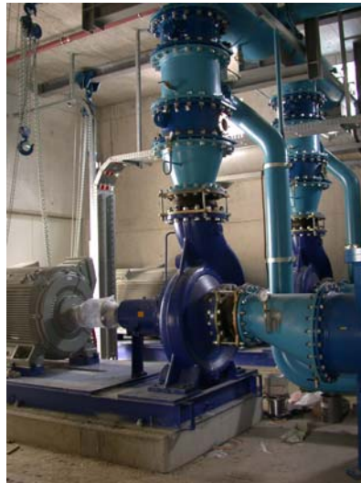
Kühlwasser Druckerhöhungspumpen
