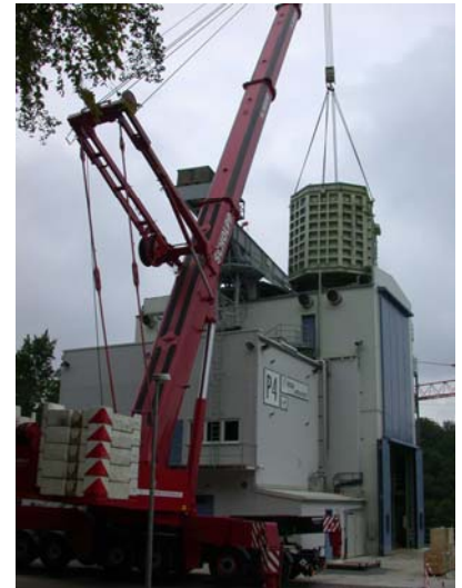
Montage Vakuumkammer
