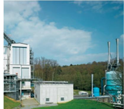
Im Höhensimulationsprüfstand P4.1 in Lampoldshausen werden die Vinci-Oberstufentriebwerke unter der Bedingung großer Flughöhen getestet
