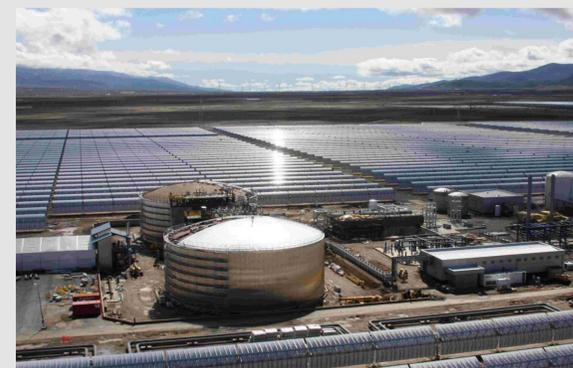
Abb. 4: Das Wärmespeichersystem von CSP-Kraftwerken ermöglicht eine bedarfsgerechte, solare Stromerzeugung. Im Bild: Andasol-Kraftwerke. Quelle: DLR
