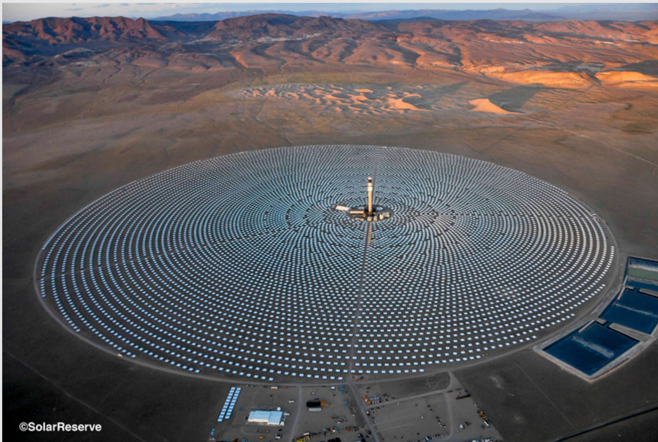
Abb. 1: Das Salzturmkraftwerk „Crescent Dunes“ mit 110 MW el in den USA. Quelle: SolarReserve
