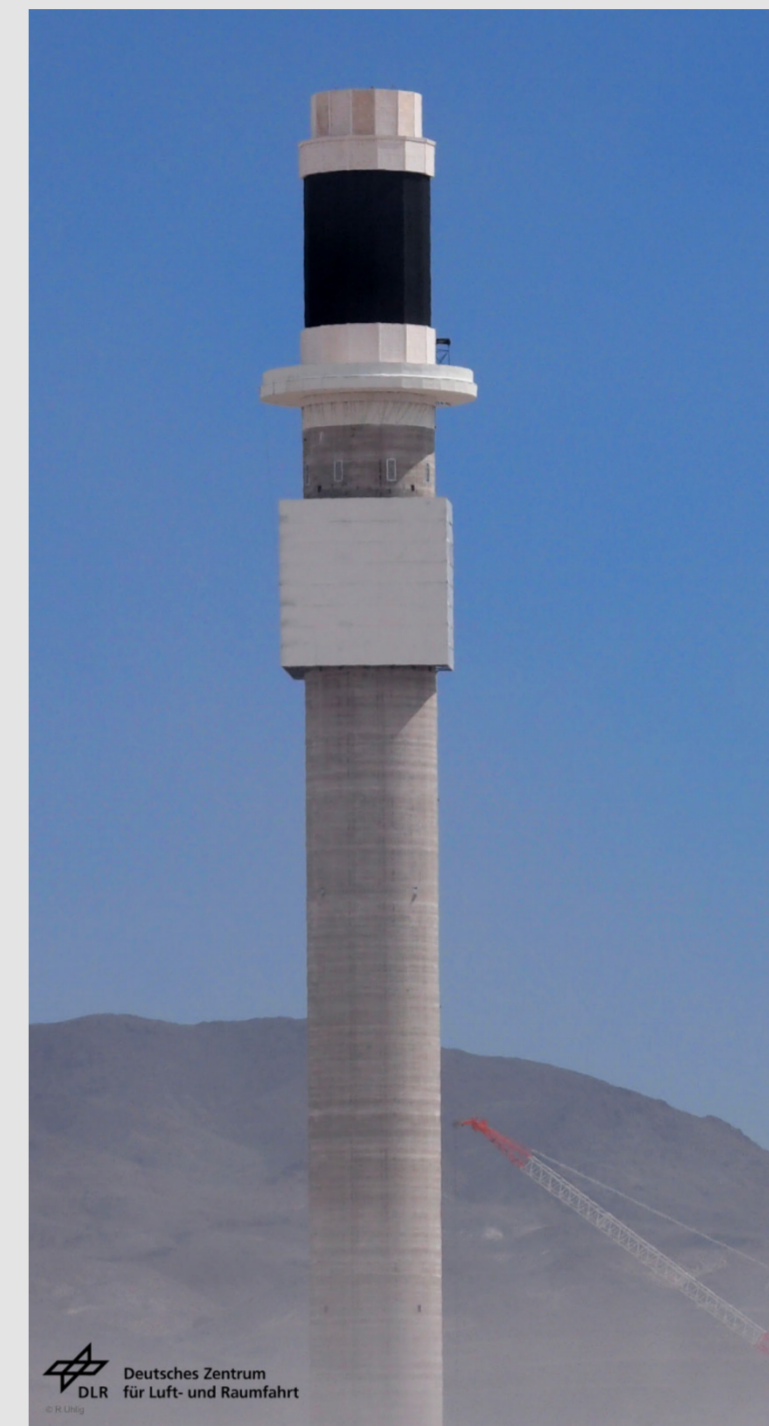
Abb. 2: Aktueller Stand der Technik: Receiver des Salzturmkraftwerks „Crescent Dunes“ in den USA. Quelle: DLR
