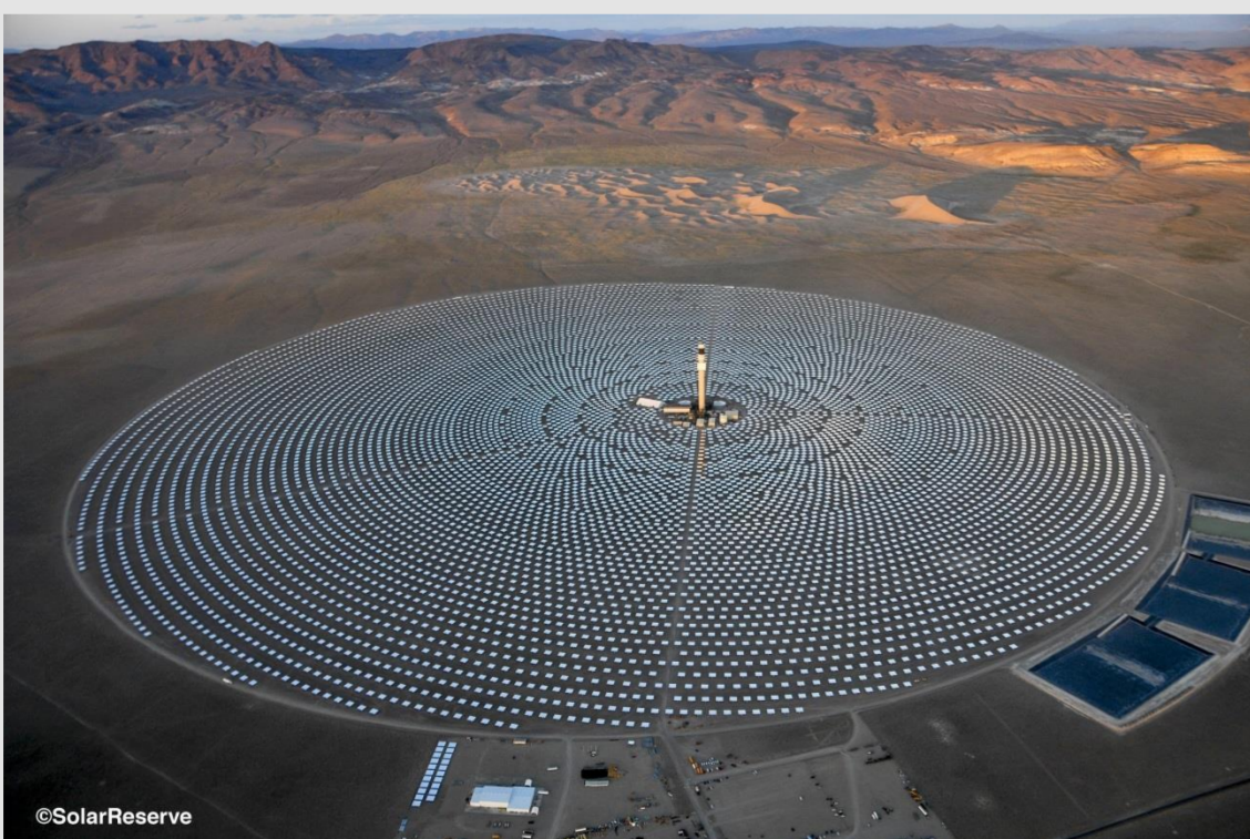
Abb2: Das Salzturmkraftwerk „Crescent Dunes“ mit 110 Mwe in den USA (Quelle: SolarReserve)
