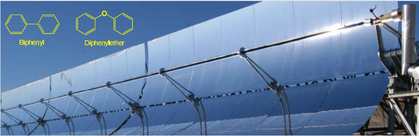
Abb. 1: Biphenyl und Diphenylether sind die Inhaltsstoffe des derzeit noch am häufigsten in solarthermischen Parabolrinnenkraftwerken eingesetzten Wärmeträgermediums.
