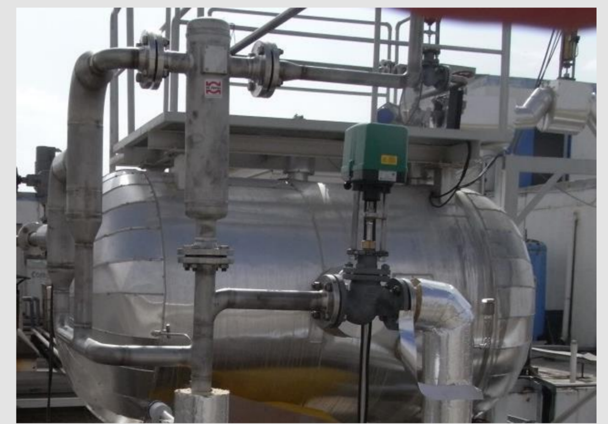
Im Vordergrund Installation des Zyklons noch unisoliert, im Hintergrund Dampftrommel bereits isoliert
