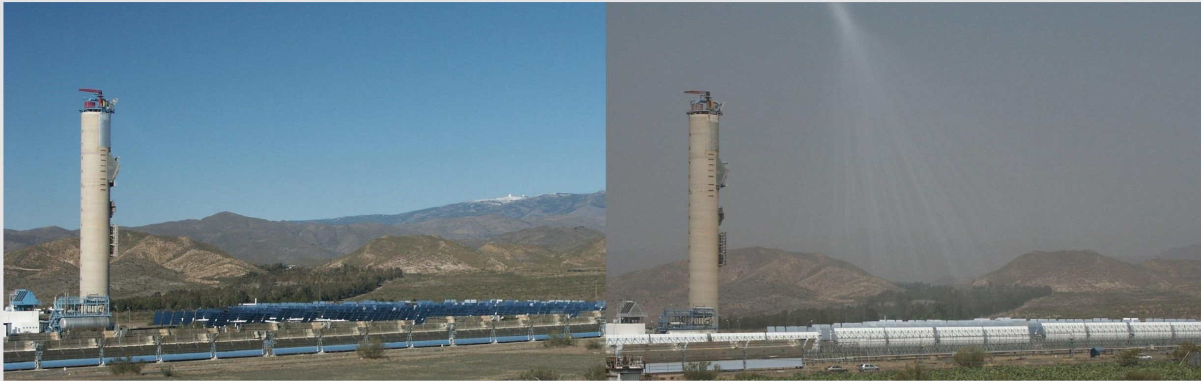
Abb.1: CESA1 Turmkraftwerk an einem typischen klaren (links) und trüben Tag (rechts) auf PSA, Spanien.
