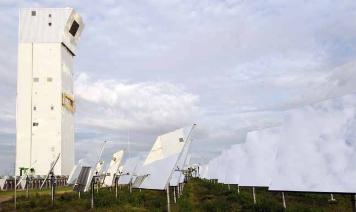
Das Solarthermische Versuchs- und Demonstrationskraftwerk im nordrhein-westfälischen Jülich
