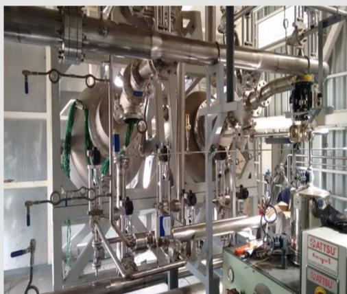
Receiver-Cluster mit Verrohrung und nachgeschalteter Peripherie
