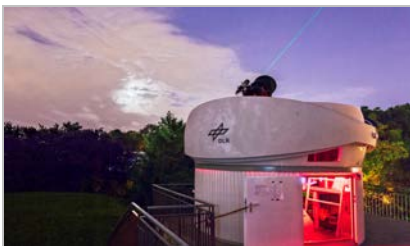
Weltraumschrott-Observatorium Stuttgart-Uhlandshöhe Space debris research observatory Stuttgart Uhlandshöhe
