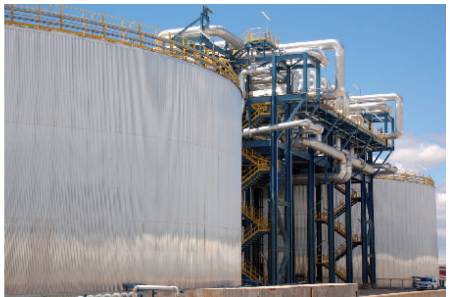
Bild 1 Flüssigsalzspeicher in einem solarthermischen Kraftwerk.
