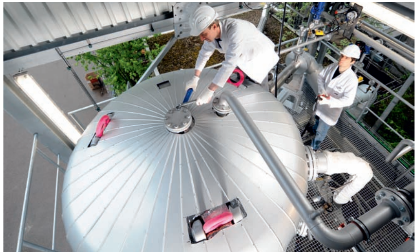
Draufsicht auf den Speicherbehälter
