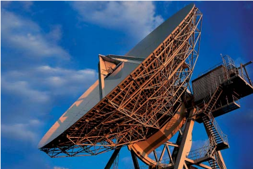
Hier müssen die Materialkennwerte und die Belastungsgrenzen bekannt sein: Die 30-Meter-Parabolantenne des Deutschen Raumfahrtkontrollzentrums in Weilheim. Bild: DLR
